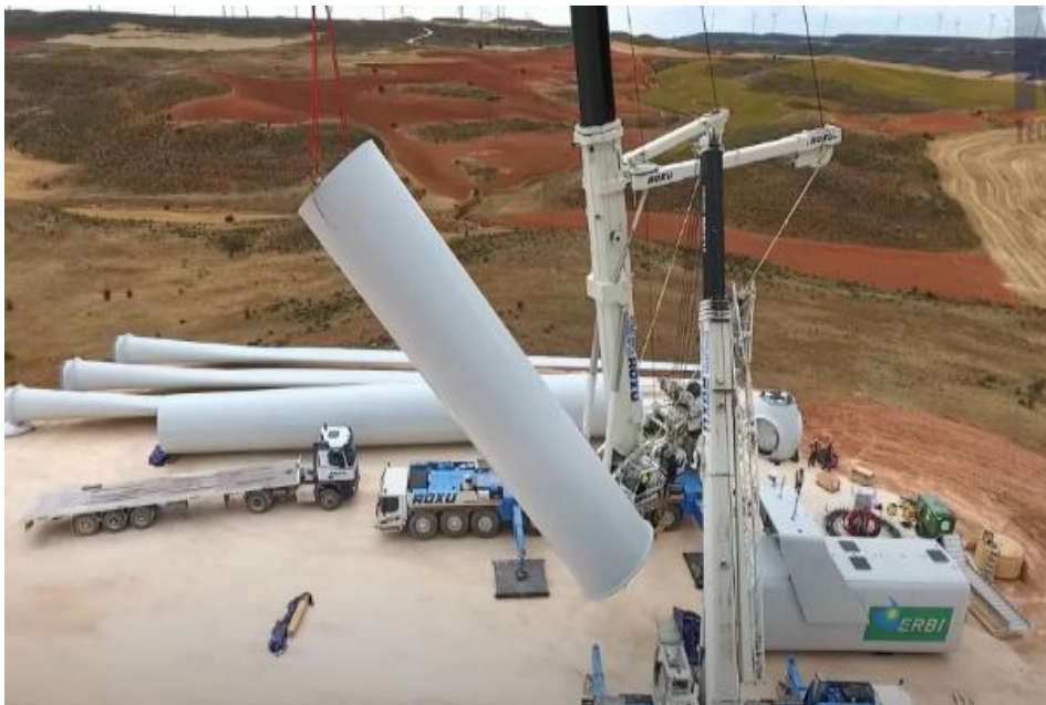
1.23. attēls. Piemērs ar VES montāžas laukumu un turbīnas uzstādīšanas procesu (ekrānuzņēmums no Quantum Tech HD)
