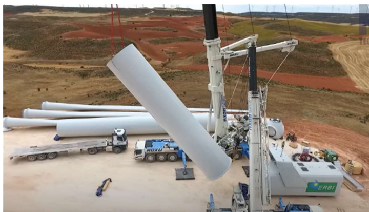
1.19. attēls. Piemērs ar VES montāžas laukumu un turbīnas uzstādīšanas procesu (ekrānuzņēmums no Quantum Tech HD)
